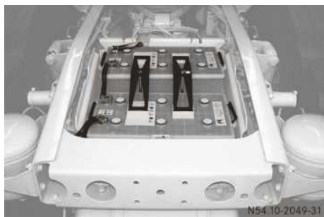
Akumulatory między podłużnicami ramy (przykład)
