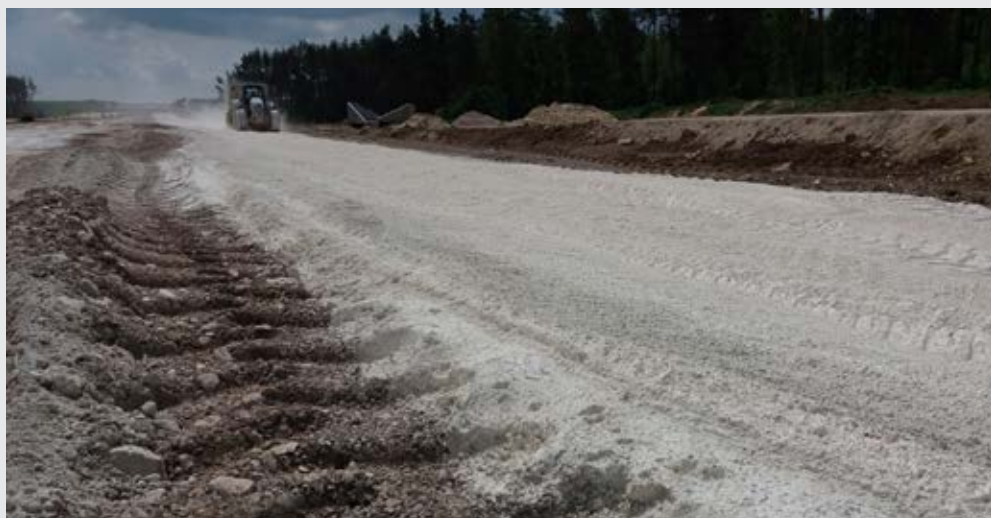
Rys. 22. Budowa podbudowy drogi S7 w Brzegach k/Kielc.
