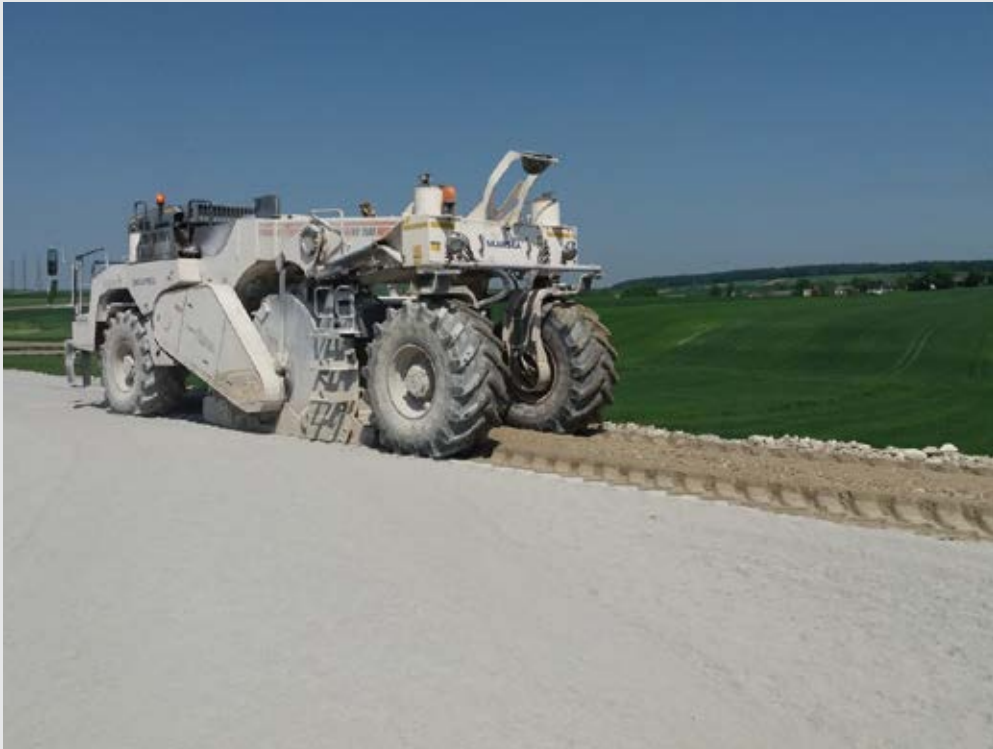
Rys. 21. Stabilizacja warstwy nasypu w ciągu obwodnicy Miechowa.
