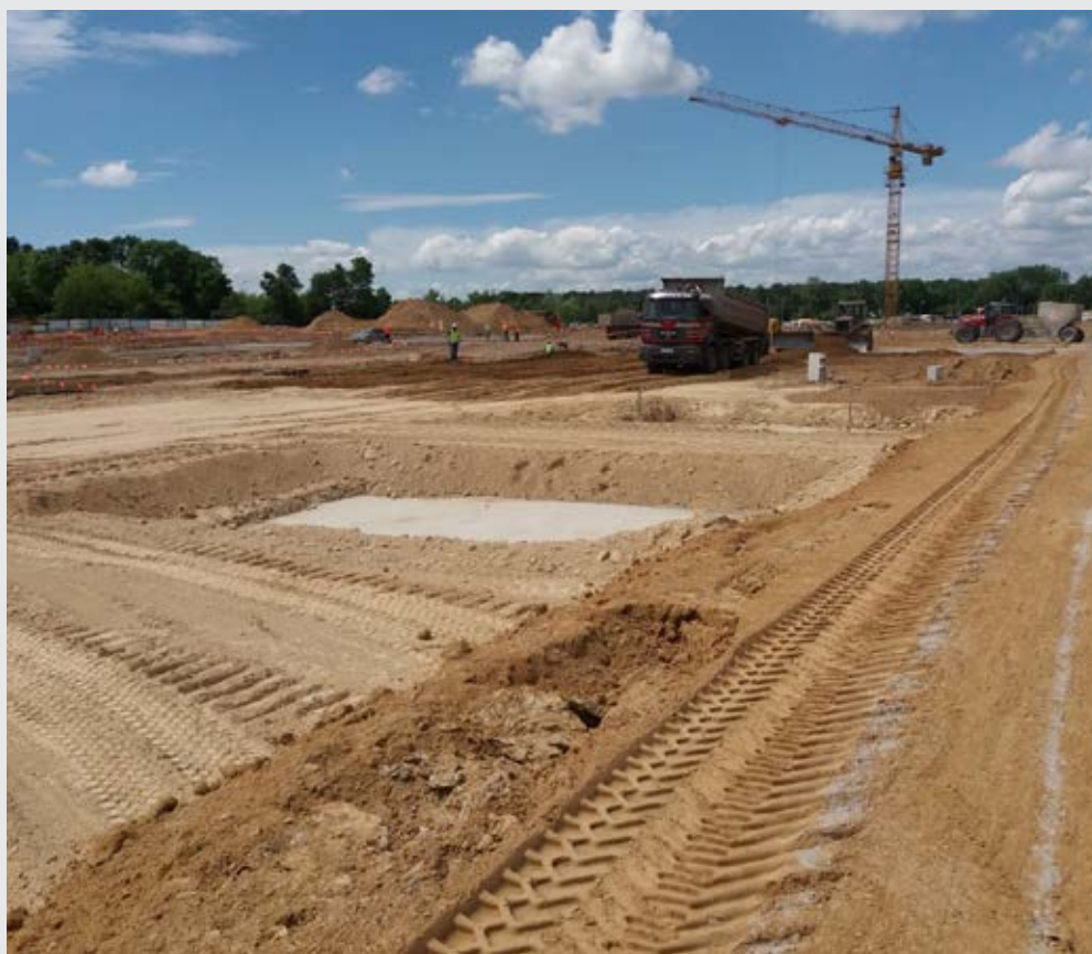
Rys. 23. Stabilizacja podłoża pod halę produkcyjno-magazynową w Siemianowicach Śląskich
