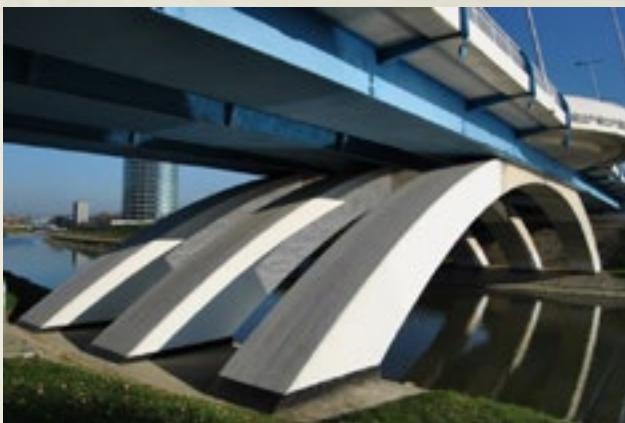
Rys. 2. Przykłady konstrukcji betonowej wykonanej z betonu SCC - most zamkowy w Rzeszowie
