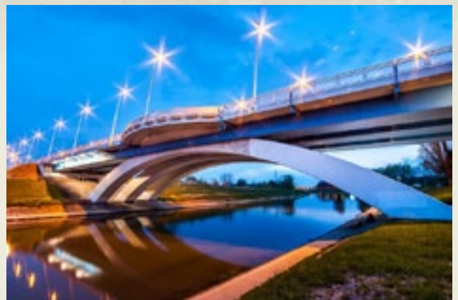
Rys. 2. Przykłady konstrukcji betonowej wykonanej z betonu SCC - most zamkowy w Rzeszowie
