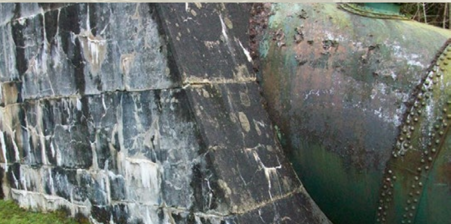
Rys. 9. Skutki reakcji alkalia-kruszywo
