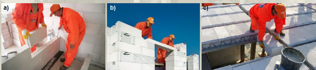
Rys. 6. Przykładowe elementy wykonane z betonu komórkowego: a) ściana wewnętrzna budynku, b) nadproże okienne, c) elementy stropowe
