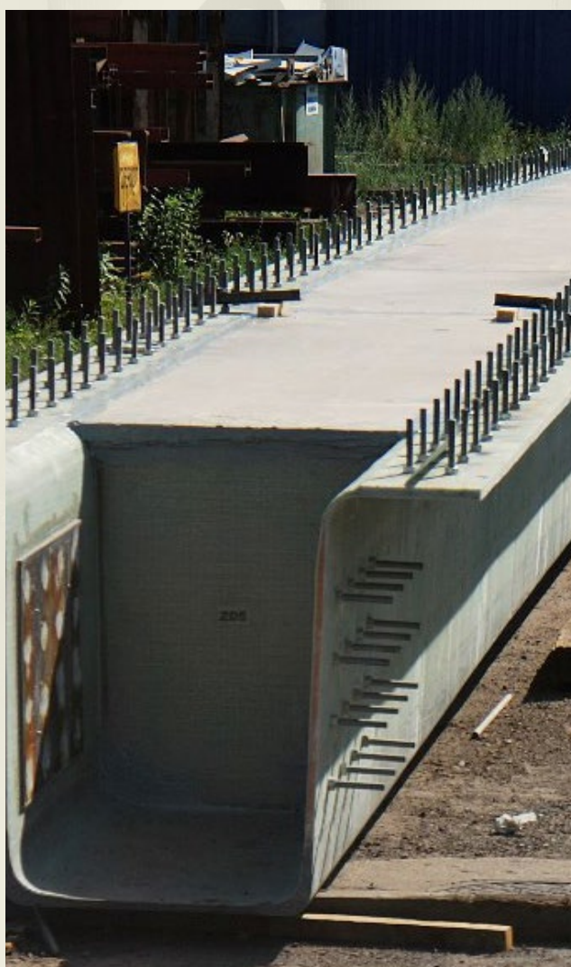
Rys. 11. Wypełnienie kompozytowej belki nośnej mostu w Białowej betonem lekkim
