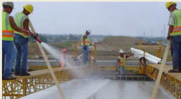
Rys. 1. Zraszanie powierzchni betonu wodą
