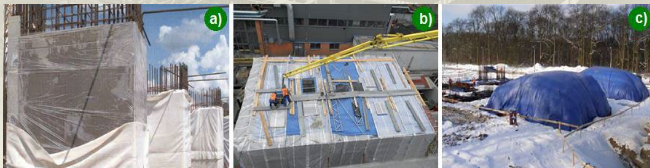
Rys. 4. Stosowanie osłon a), b) przykrywanie powierzchni betonu folią, c) stosowanie namiotów
